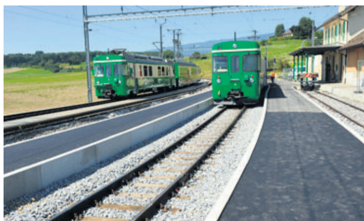
Les vandales ont causé quelque 350 000 francs de dégâts! Maeder
