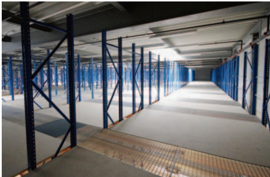
Les locaux sis au chemin de Préveyres 55, à Lully, pour l'instant encore vides, disposent de près de 40 kilomètres de capacité de stockage.
