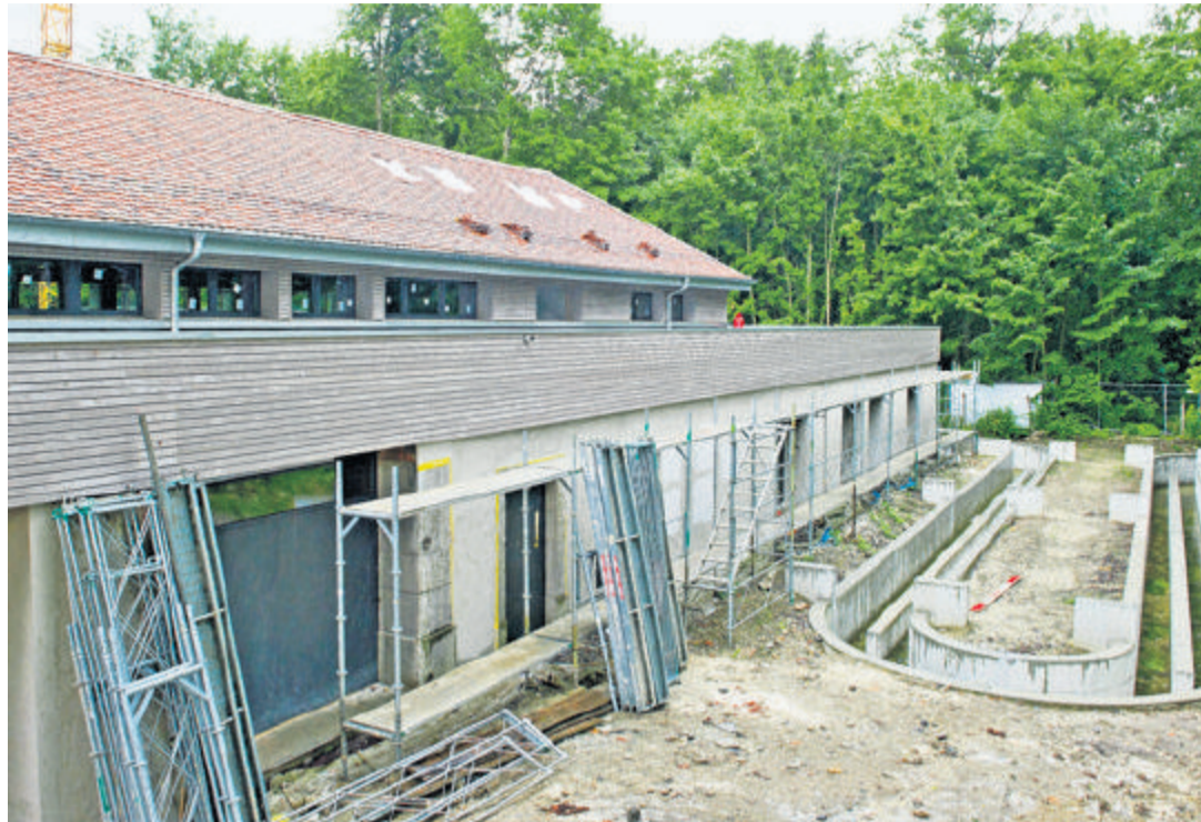
La Maison de la Rivière devrait ouvrir ses portes au public début 2015. Un canal en béton, qui reconstitue tout l'environnement d'un cours d'eau, fait partie des infrastructures. V. CARDOSO
