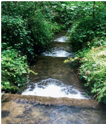
Amélioration des seuils en bois pour faciliter la migration des truites.
