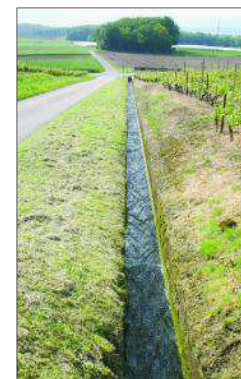
Un canal de drainage vers le décanteur.
