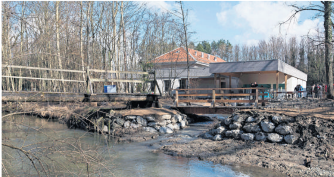
En cas de sécheresse ou de pollution, les vannes seront fermées. L'eau du lac prendra le relais.
