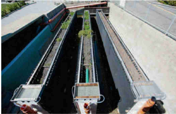
Trois murs filtrant les produits phytosanitaires ont été installés dans un ancien décanteur. ARCHIVES SIGFREDO HARO
