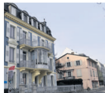
De g. à dr. immeubles 32 et 30 de la rue des Charpentiers.
