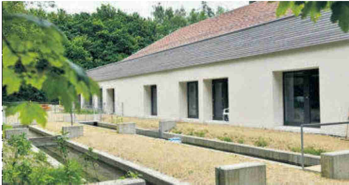
La Maison de la Rivière vue de l'extérieur.
